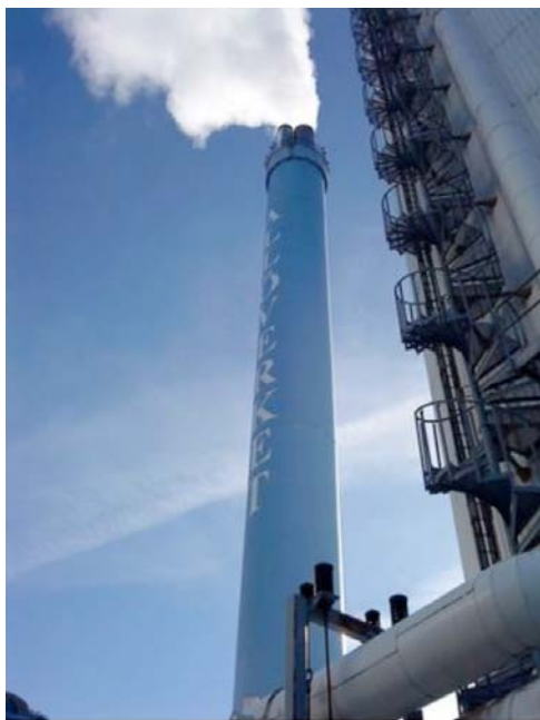
Station de méthanisation des déchets.
