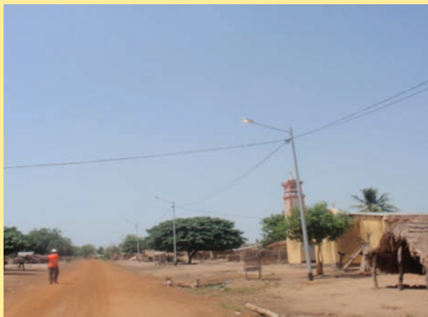
Electrification du village d'Oligo par l'énergie de la PTFM
