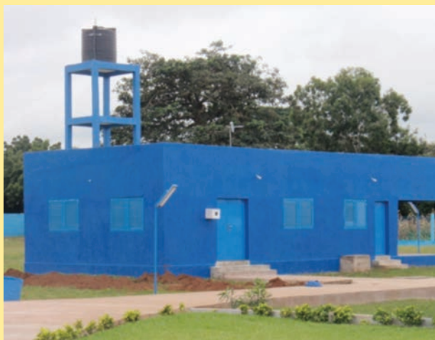
Bâtiment abritant la Blue PTFM dans le quartier Cacavéli à Lomé
