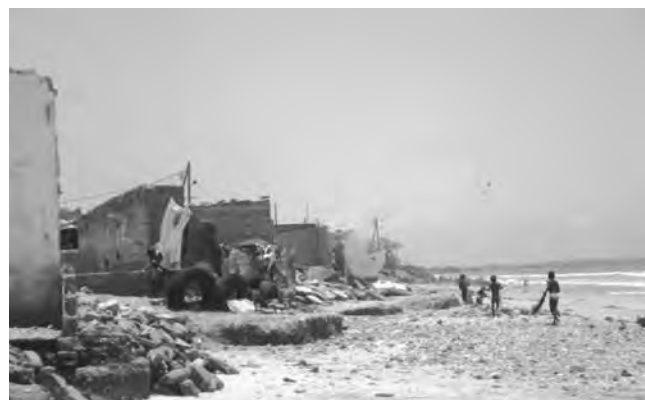
Photo 1: Maisons détruites à Bargny
