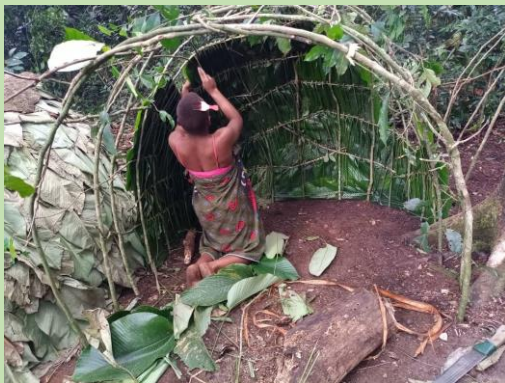
Fig. 1 : Construction des abris avec les matériaux locaux
