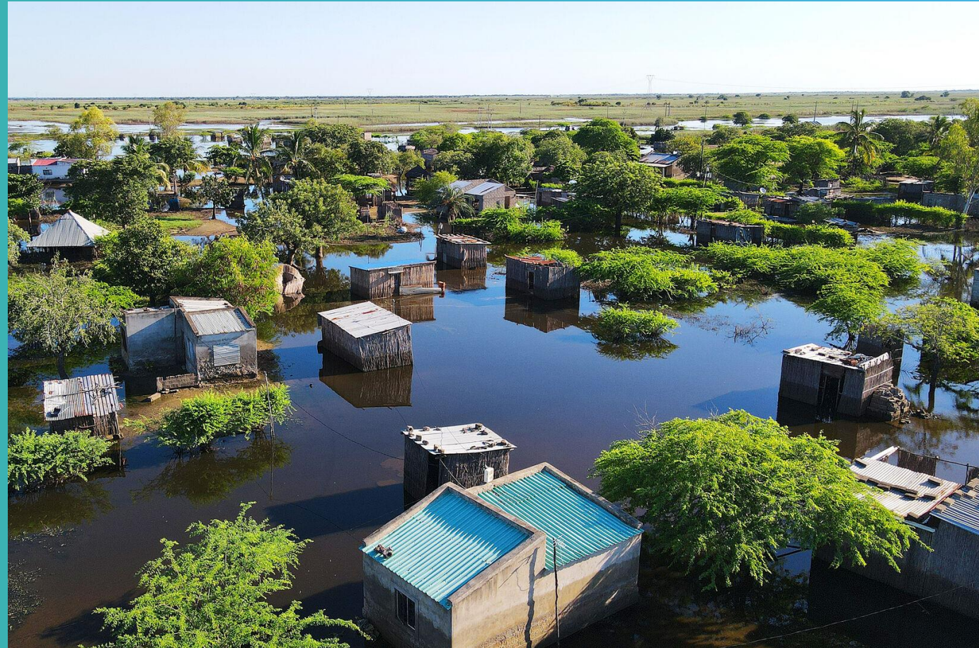
Des maisons submergées par les eaux de crue à Chiaquelane, dans le district de Chókwè. 02/18/2026. Mozambique
